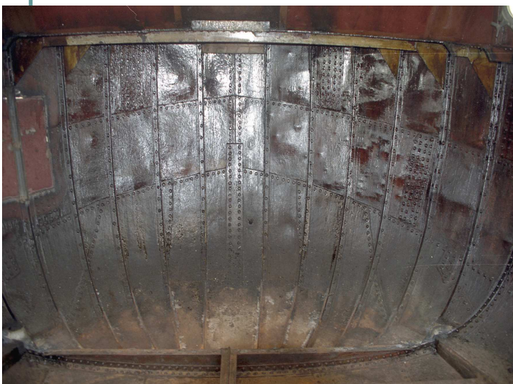
De geklonken binnenzijde van kop van de "Broedertrouw".
